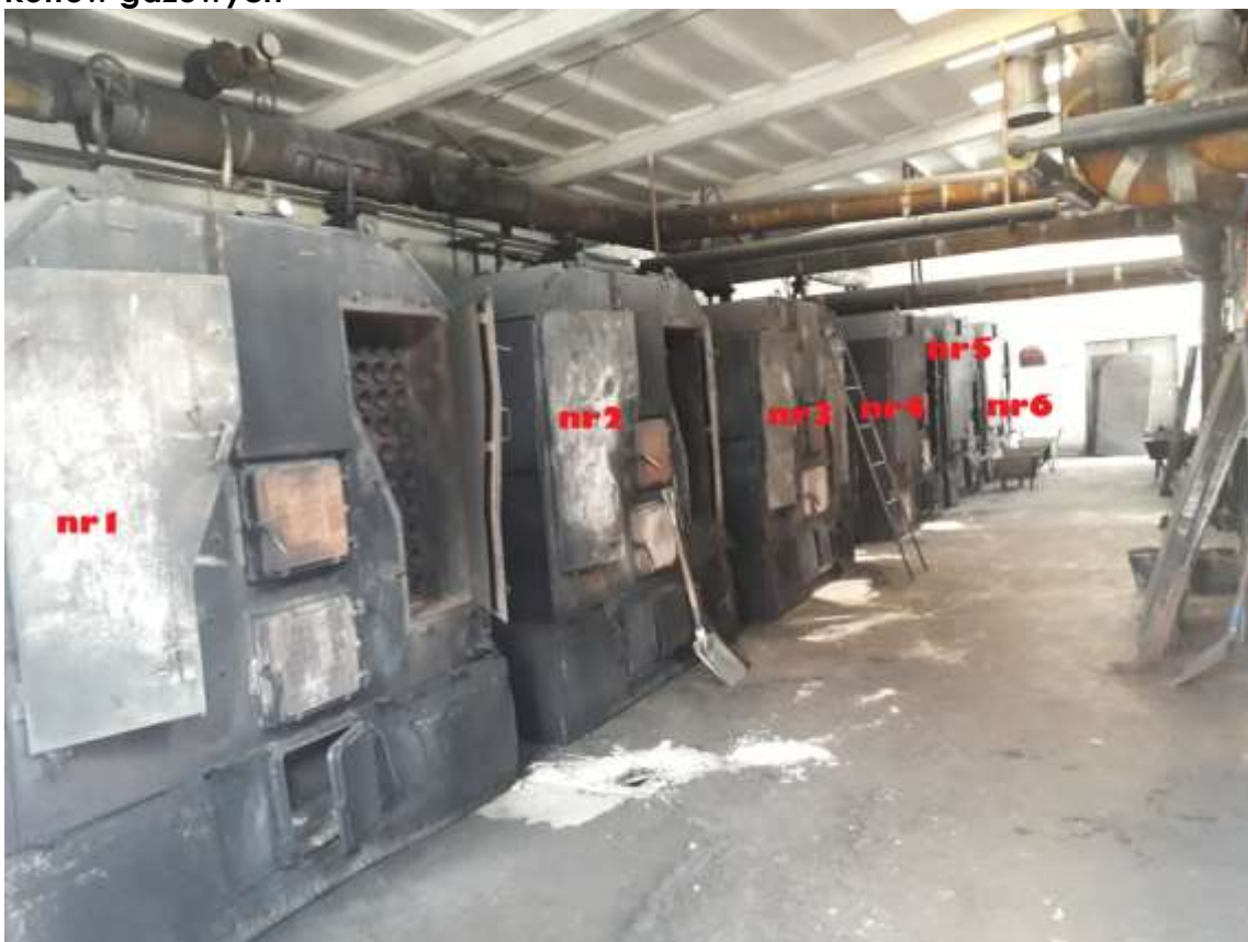
Zdjęcie nr 12 - istniejące kotły węglowe do demontażu, miejsce montażu nowych kotłów gazowych
