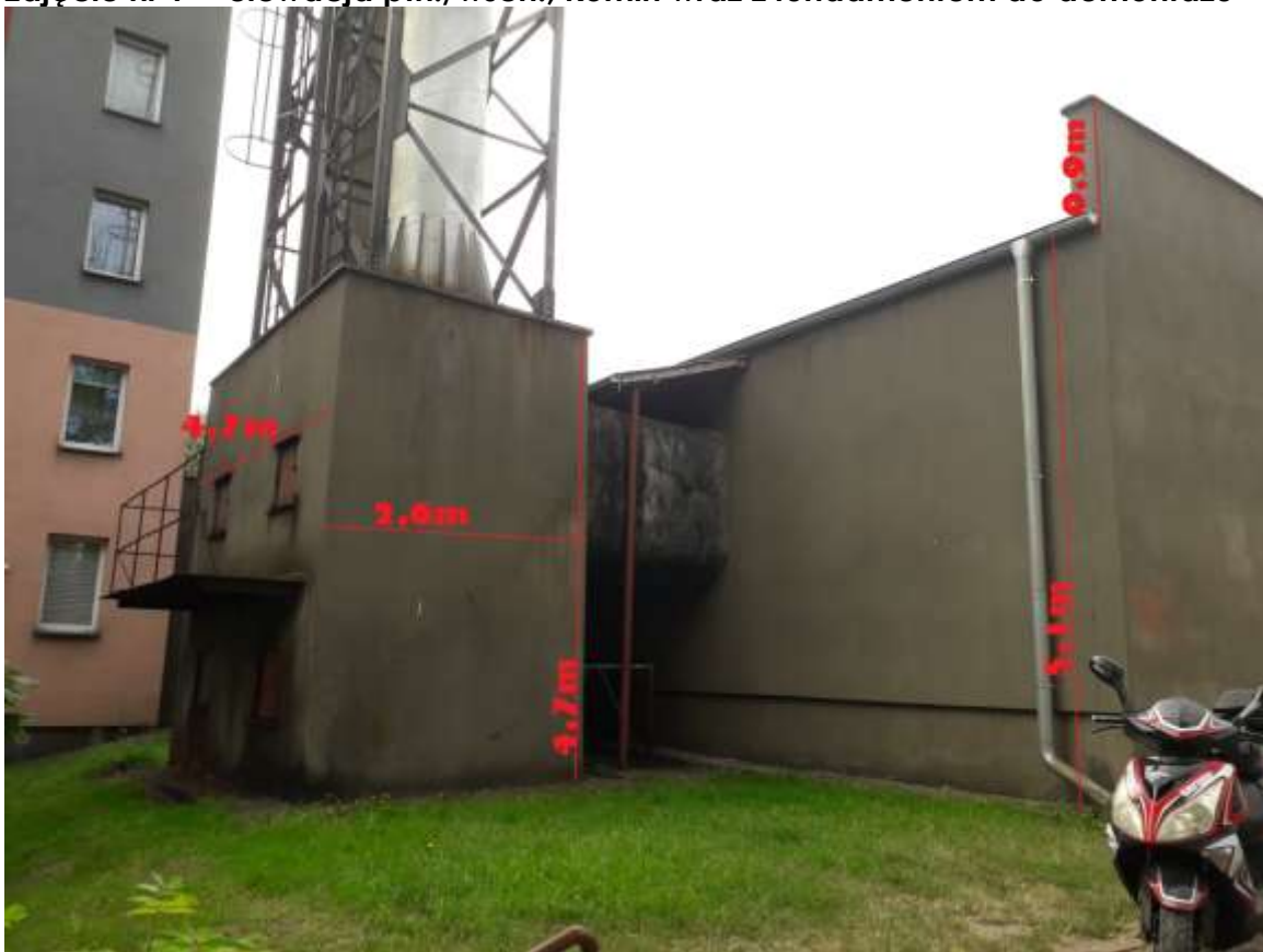
Zdjęcie nr 2 - elewacja płn./wsch., komin wraz z fundamentem do demontażu
