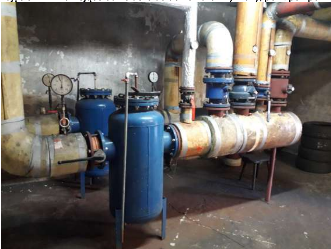
Zdjęcie nr 14 - istniejące odmulacze do demontażu i wymiany, pom. pompowni
