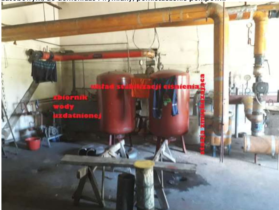
Zdjęcie nr 16 - układ stabilizacji ciśnienia, stacja zmiękczenia wody ze zbiornikiem zasobowym, do demontażu i wymiany, pomieszczenie pompowni
