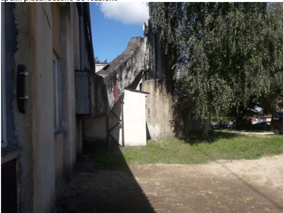
Zdjęcie nr 6 - dobudówka, komin z fundamentami i instalacją odprowadzenia spalin przeznaczone do rozbiórki
