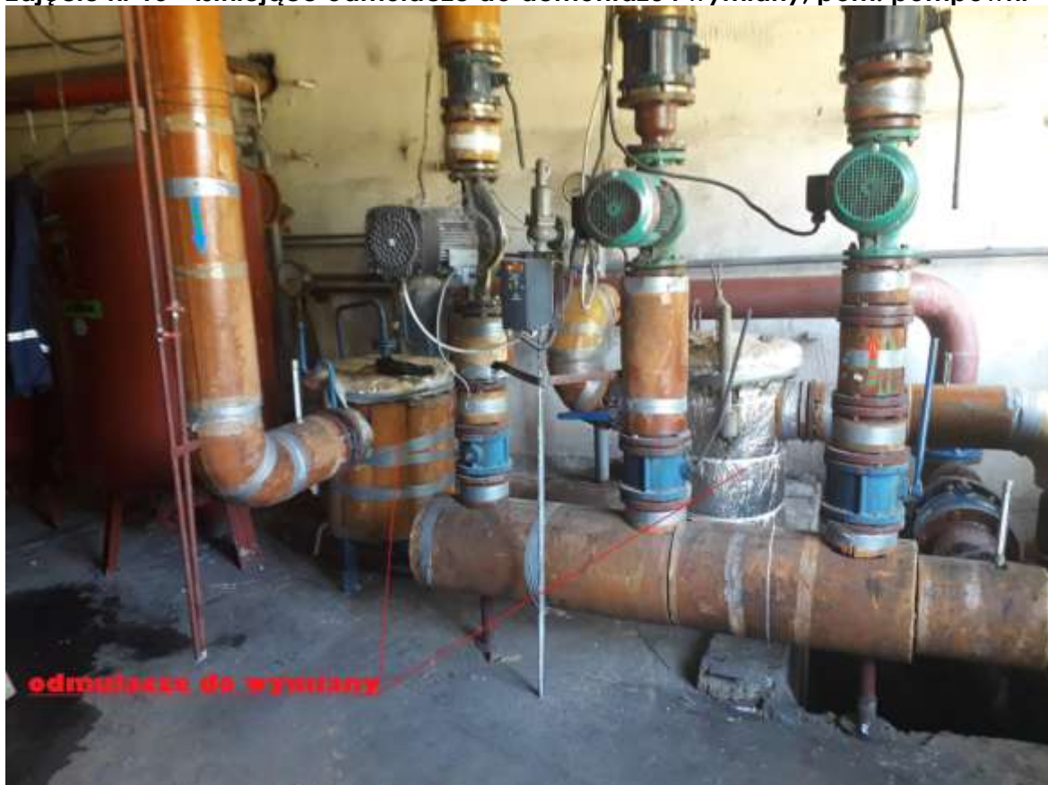
Zdjęcie nr 16 - układ stabilizacji ciśnienia, stacja zmiękczenia wody ze zbiornikiem zasobowym, do demontażu i wymiany, pomieszczenie pompowni
