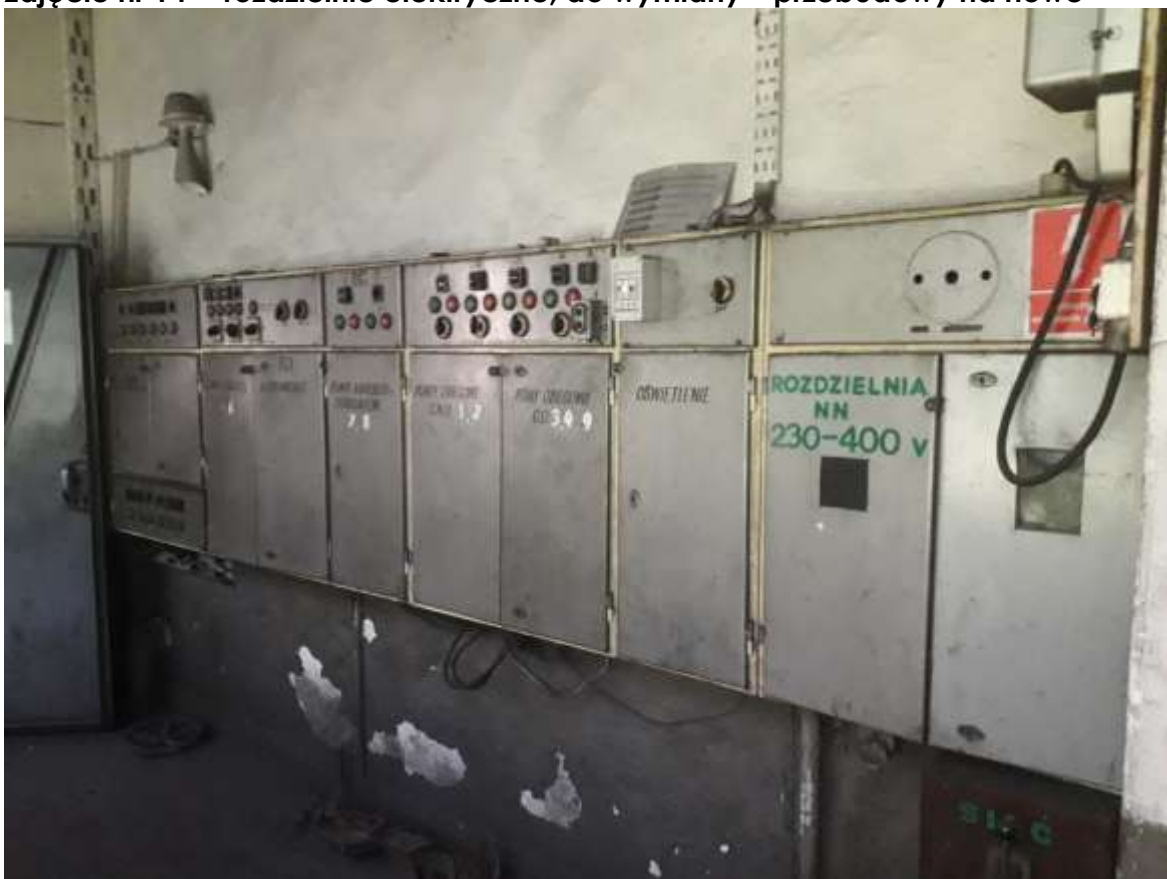
Zdjęcie nr 14 - rozdzielnie elektryczne, do wymiany – przebudowy na nowe
