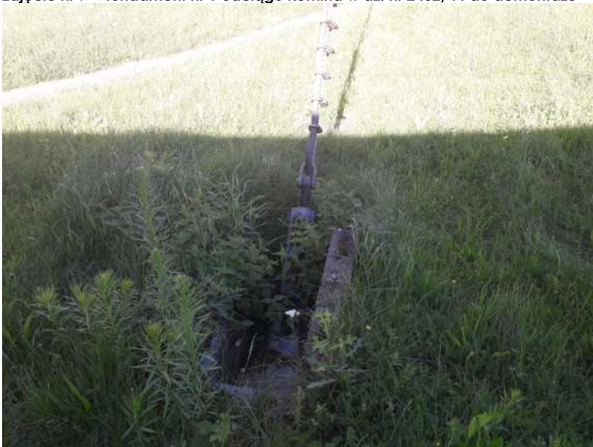
Zdjęcie nr 8 - fundament nr 2 odciągu komina w dz. nr 2402/44 do demontażu
